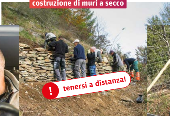
costruzione di muri a secco
