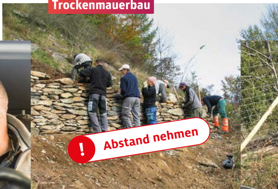
Trockenmauerbau
